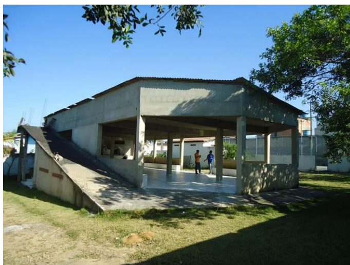
Visão Externa Salão de Eventos
