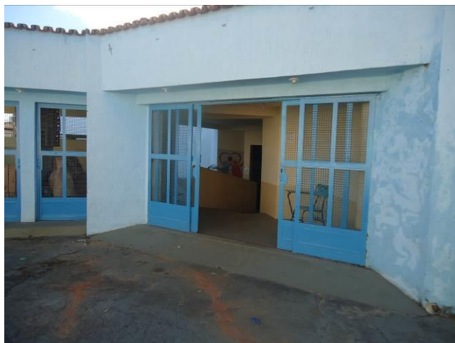
Visão Externa Acesso ao Salão Principal
